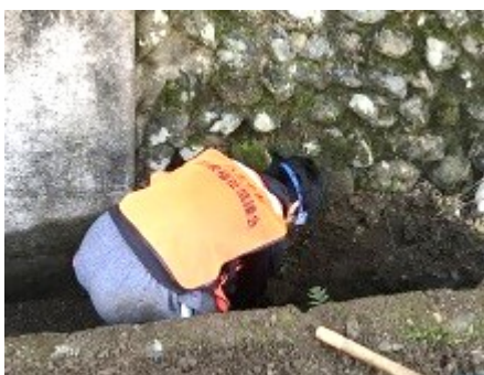
水路は意外と深く、土砂を運び上げるのは大変でした。
