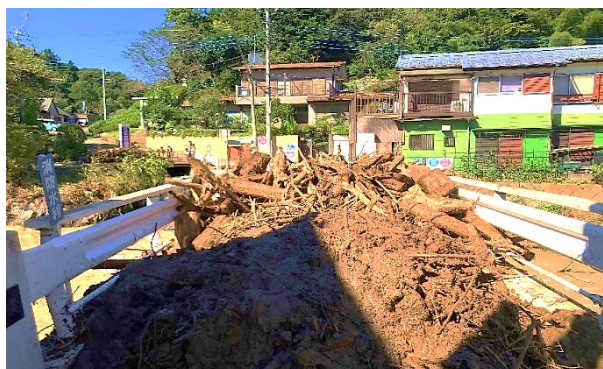
令和元年10月13日 被害を受けた白山橋
