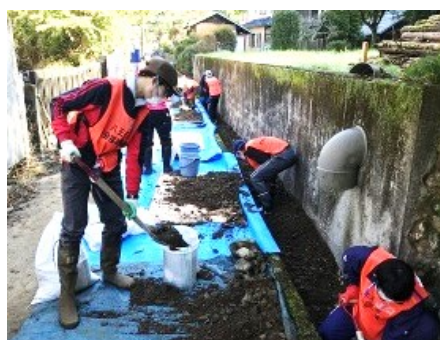
土砂を土のうに詰めます。
