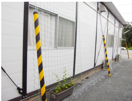
相馬市内の仮設住宅
